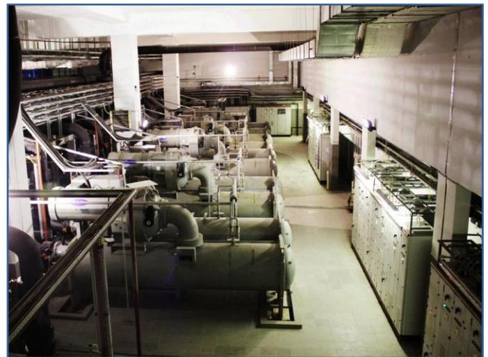
Полноценный климат-контроль в наших широтах невозможен без эффективной системы теплоснабжения. Ее бесперебойная работа обеспечивается двумя независимыми источниками тепла и двумя тепловыми пунктами мощностью 22 и 15 Гкал/час.
