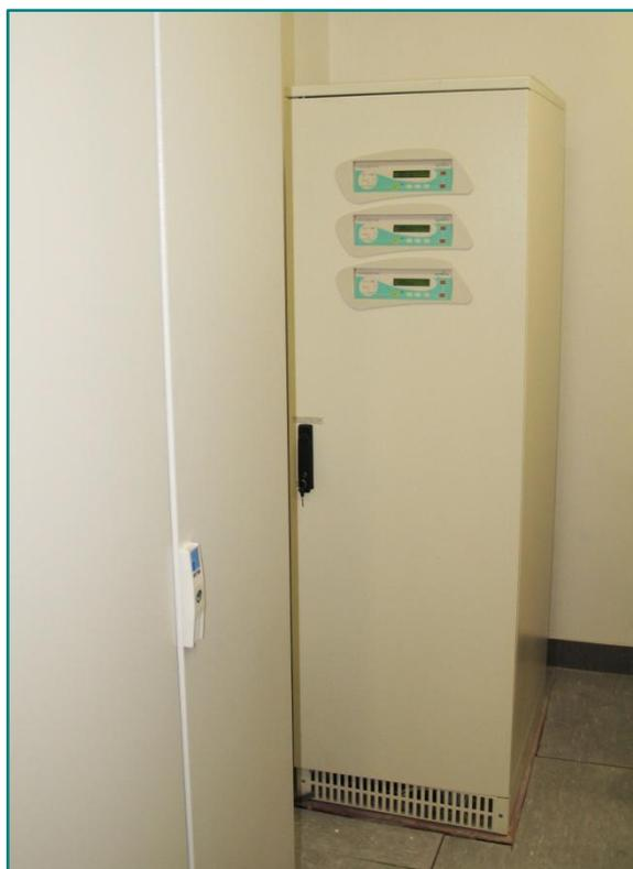
Система бесперебойного электроснабжения обеспечивает работу информационных систем, систем безопасности и диспетчеризации в течение не менее 30 минут.
