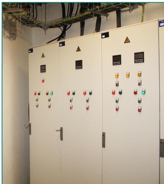
На каждом этаже штаб-квартиры банка расположены трех-четырёх модульные системы ИБП Newave Conceptpower Upgrade & DPA Upgrade, мощностью 90-100 кВА. Всего - 32 этажные масштабируемые системы с двойным преобразованием и децентрализованным управлением второго поколения. Технические возможности ИБП Newave обусловили ряд преимуществ их использования для банковских предприятий:
