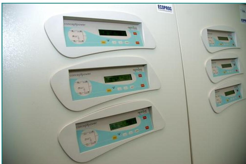
Повышение эффективности эксплуатации оборудования обеспечено возможностями дистанционного мониторинга параметров ИБП, а в аварийной ситуации мгновенной передачей SMS-сообщений на мобильные телефоны соответствующих служб.
