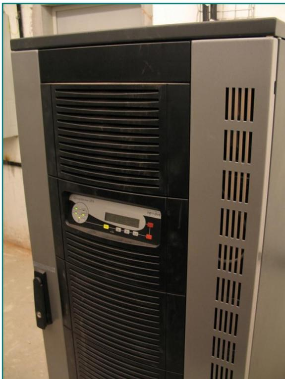
Модернизация систем электроснабжения заключалась в интеграции существующих источников Newave Conceptpower Gemini с вновь устанавливаемыми ИБП Newave Conceptpower Modular линии Upgrade с высокой степенью надёжности, которая достигается не только конструкцией источников, но и параллельным включением всех имеющихся модулей на одну нагрузку и возможностью наращивания мощности системы.
